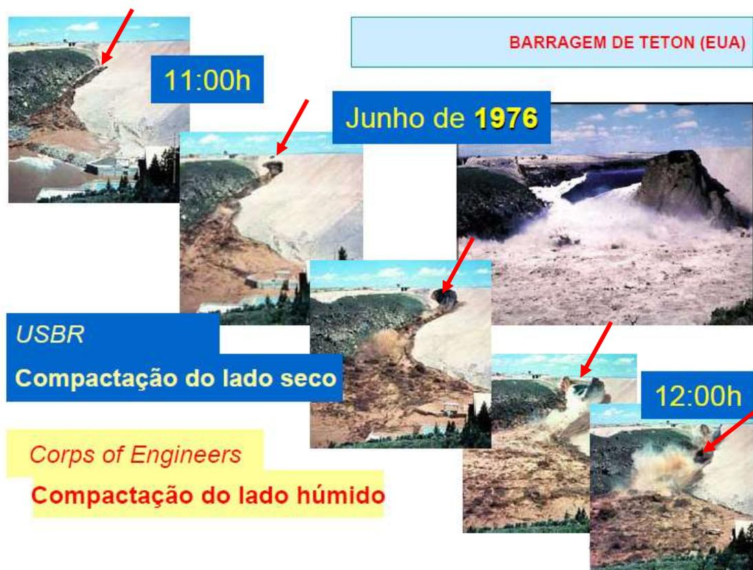
**Figura 24** – Evolução da brecha de ruptura por *piping* da Barragem de Teton. As setas em vermelho realçam a evolução da brecha ao longo da última hora do momento da ruptura
