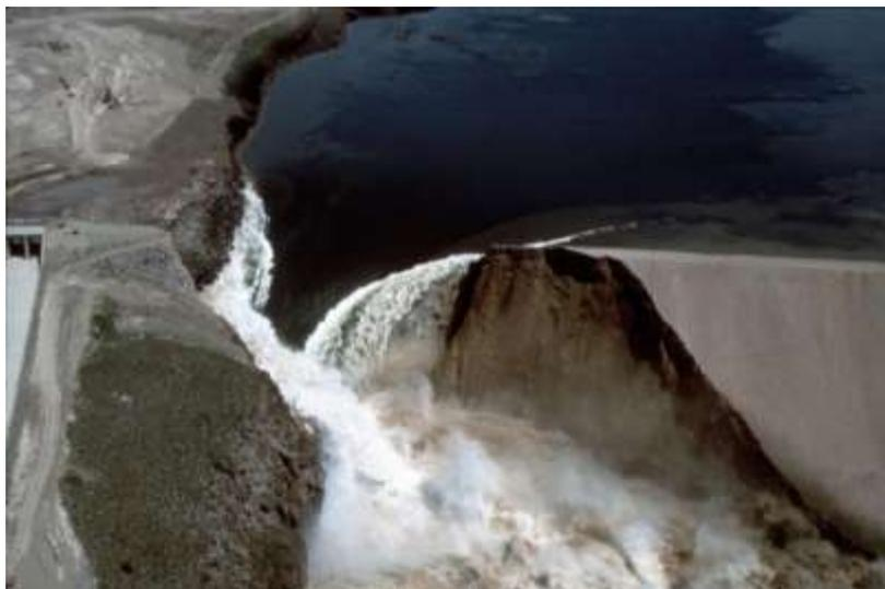
**Figura 23** - Vista aérea da brecha de ruptura da Barragem de Teton – EUA
