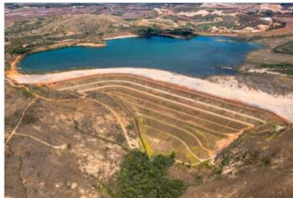
**Figura 4** - Barragens alteadas pelo método de montante: Barragem I da Mina de Gongo Soco e Barragem Forquilha III da Mina de Fábrica
