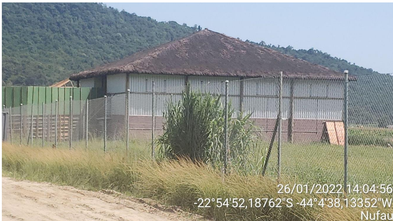
Figura 63. Visão da área de cambiamento (com cobertura de palha) e atrás (com tapumes verdes) área de recinto em construção e à frente, (com cerca telada) onde seria o segundo piquete de área de soltura, ainda não construído. A cerca telada não é capaz de conter uma girafa.
