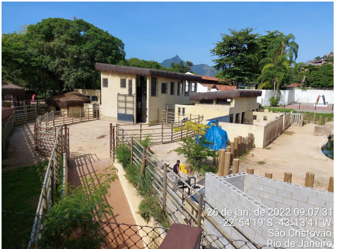
Figura 58. Vista externa da área de cambiamento para as girafas no Riozoo. Existem quatro cambiamentos dentro da estrutura maior ao fundo. Ou seja, indica-se a pretensão de receber e manter apenas quatro girafas, no máximo, frente às 18 importadas.
