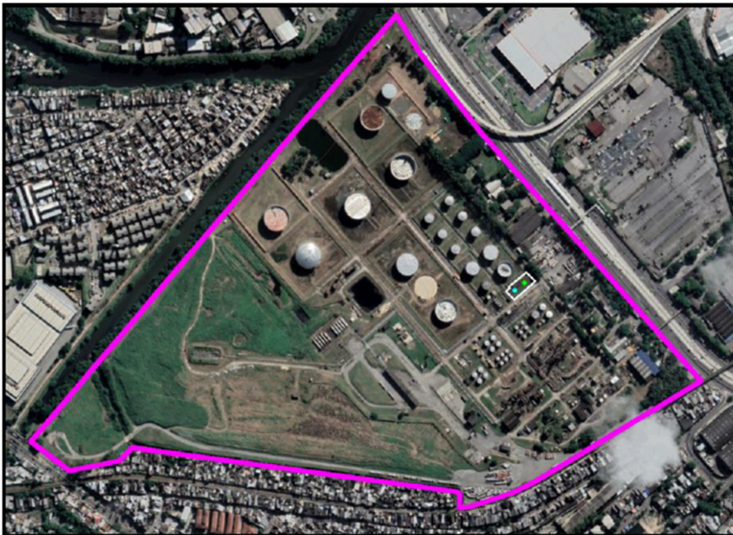
Figura 1: Vista Aérea da REFIT com a localização dos tanques demarcada em branco (Estudo de Análise de Riscos dos Tanques de Armazenamento F-222A/B, dezembro /2023).
