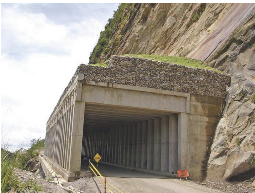
Figura 1 – Exemplo Falso Túnel
