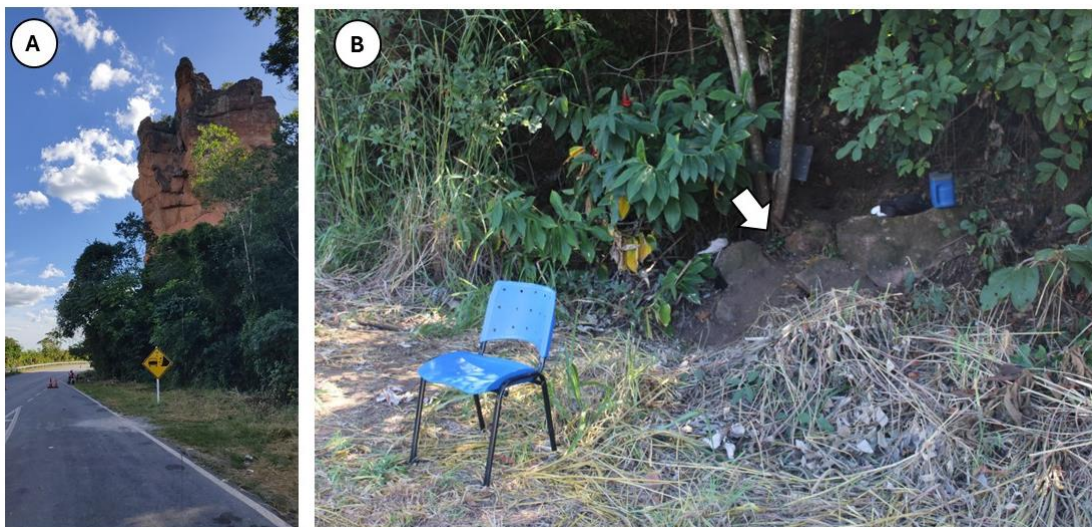
Figura 45: (A) escarpa de arenito da formação Botucatu situado próximo a MT 251, nas proximidades da Curva da Mata Fria; (B) depósitos de talus com blocos de rocha depositados a margem da rodovia.
