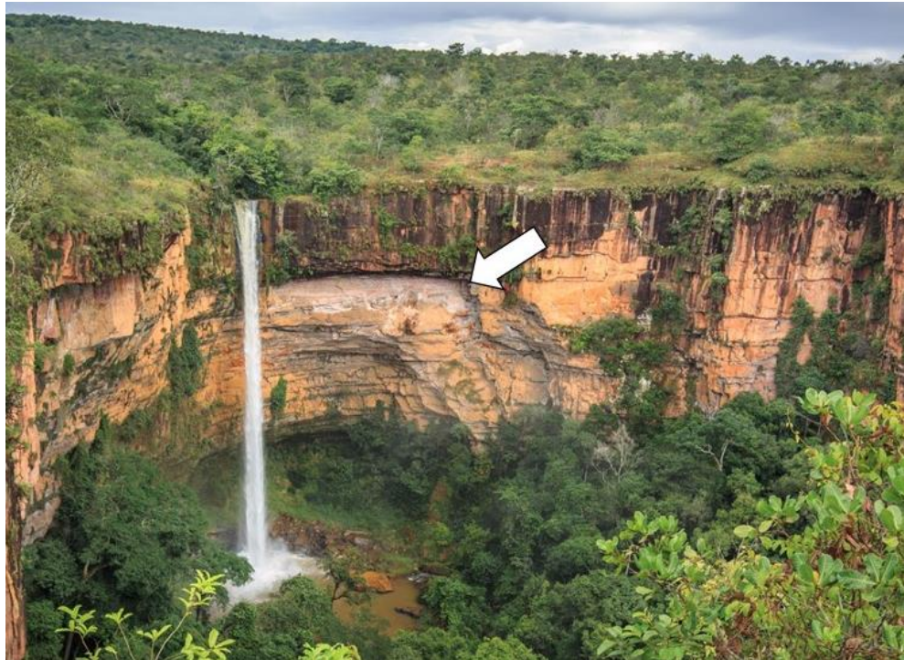
Figura 14: Cachoeira do Véu de Noiva, a seta indica o local onde ocorreu o desprendimento do bloco, sendo a área da escarpa onde possui um arenito com coloração mais clara.
