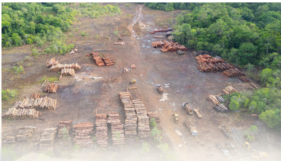
Canteiro de desmatamento.
