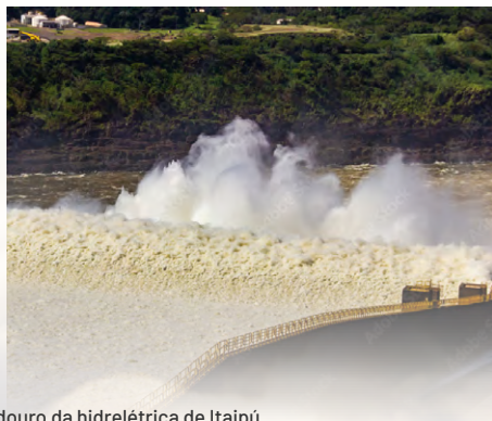
Vertedouro da hidrelétrica de Itaipú.
