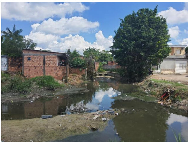
Figura 16 – Igarapé com ocupações irregulares em sua planície de inundação, assoreado e com restrição de fluxo por obra mal dimensionada. (Autores)
