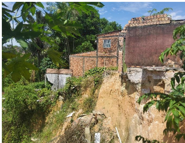
Figura 13 - Cicatriz de deslizamento antigo e sinais de movimentação no terreno. (Autores)
