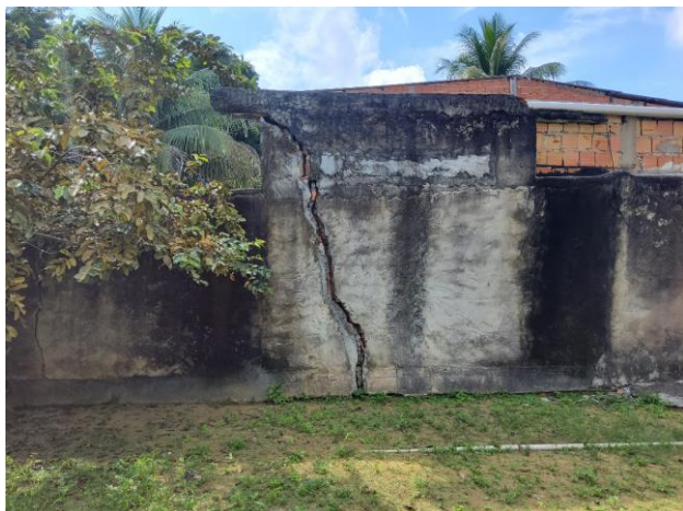
Figura 12- Muro e residência com rachadura, sinal de movimentação no terreno. (Autores)
